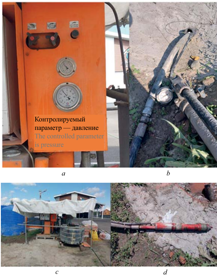
Рис. 5. Общий вид оборудования: a — датчик контроля давления; b — станция для подачи гидравлического масла; c — миксерная станция; d — гидравлический пакер
