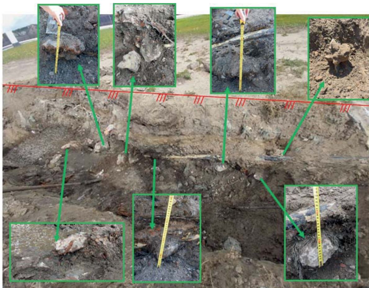
Рис. 7. Общий вид откопанного участка Fig. 7. General view of the excavated area
