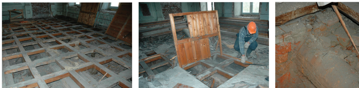
Рис. 7. Конструкция пола первого этажа (фотографии А.И. Клименко, 2002 г.)
