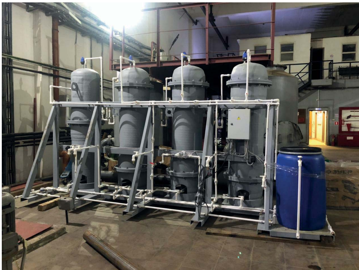
Рис. 3. Внешний вид ОПУ очистки поверхностных сточных вод, размещенной в здании действующих очистных сооружений ливневой канализации «Кожуховский пруд» (ГУП «Мосводосток»)
