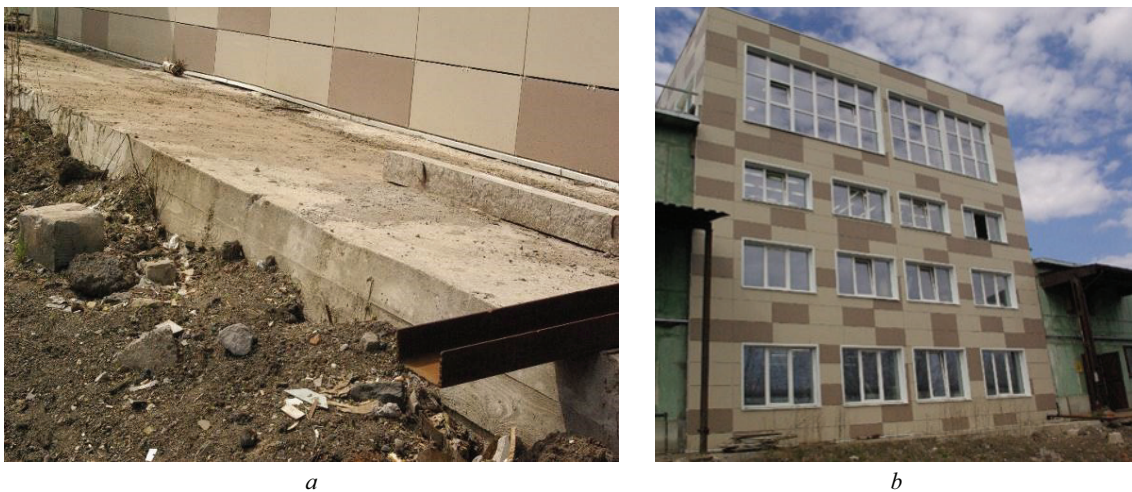
Рис. 4. Фундаментные плиты (а) и производственное здание под швейный цех по ул. Голубева, г. Ижевск (б) (фотоматериалы предоставлены ООО «КомАР»)
