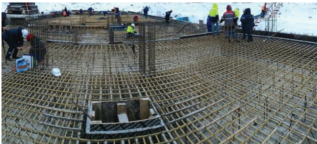
Рис. 5. Общий вид армирования фундаментной плиты 15-этажного жилого дома в ЖК «Саларьево Парк», г. Москва (URL: https://galencomposite.ru/ ; URL: https://mgsu.ru )
