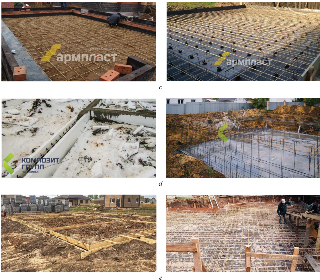
Рис. 1. Общий вид бетонных фундаментов, армированных АКП от различных производителей, для малоэтажных зданий (использованы фотоматериалы из открытых интернет-ресурсов): a — ООО «Гален» (URL: https://www.galencomposite.ru/ ); b — АО «ХЭЛП Композит» (URL: https://helpcomposite.ru/ ); c — ГК «Армпласт» (URL: https://arm-plast.ru/ ); d — ООО «КОМПОЗИТ ГРУПП ЧЕЛЯБИНСК» (URL: http://compositgroup74.ru/ ); e — ООО «Композит 21» (URL: https://21kompozit.ru/ ) Fig. 1. General view of concrete foundations reinforced with FRP from various manufacturers for low-rise buildings (photo materials from open Internet resources were used): a — “Galen” LLC (URL: https://www.galencomposite.ru/ ); b — “HELP Composite” JSC (URL: https://helpcomposite.ru/ ); c — “Armplast” Group of Companies (URL: https://arm-plast.ru/ ); d — “KOMPOZIT GROUP CHELYABINSK” LLC (URL: http://compositgroup74.ru/ ); e — “Kompozit 21” LLC (URL: https://21kompozit.ru/ )
