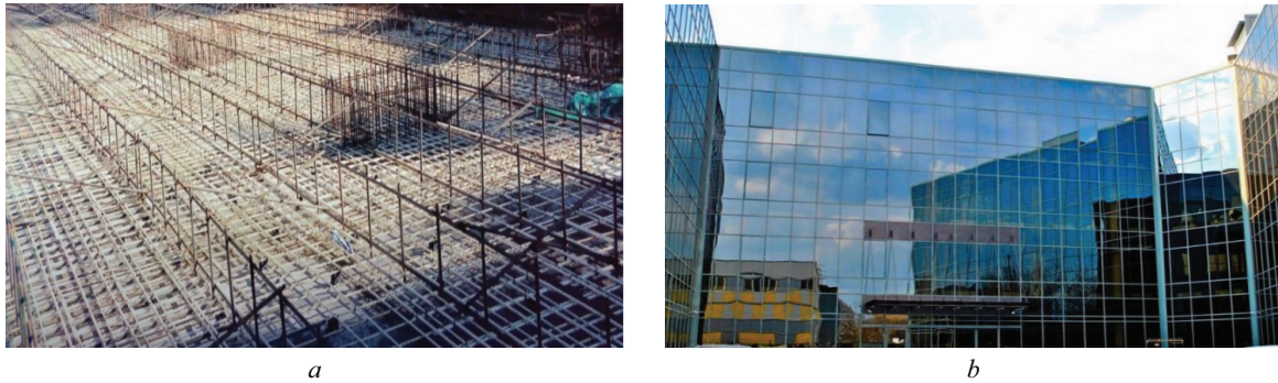
Рис. 3. Общий вид армирования фундаментной плиты (а) и офисного здания по ул. Буракова, г. Москва (б) (фотоматериалы предоставлены Ассоциацией «Композитные строительные материалы»)
