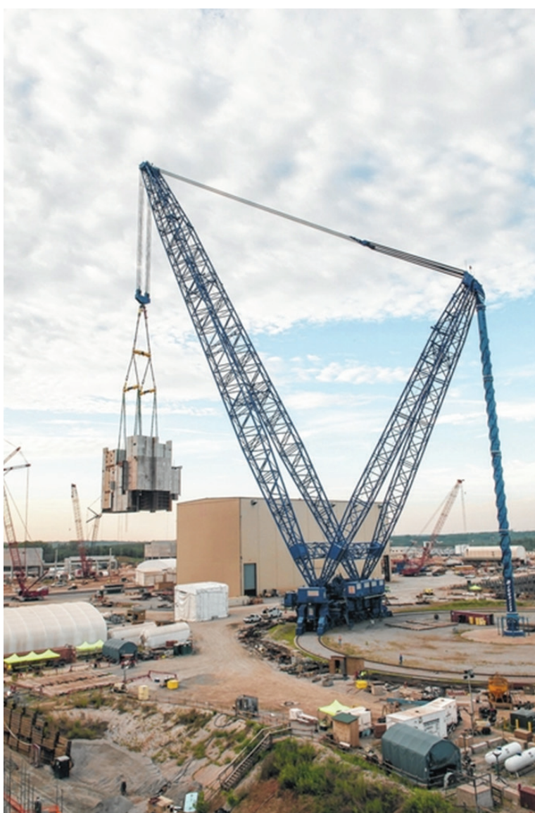
Рис. 16. Монтаж блока СА01 сверхмощным краном Bigge 125D A-Frame Ring Derrick на АЭС V.C. Summer (США) 13
