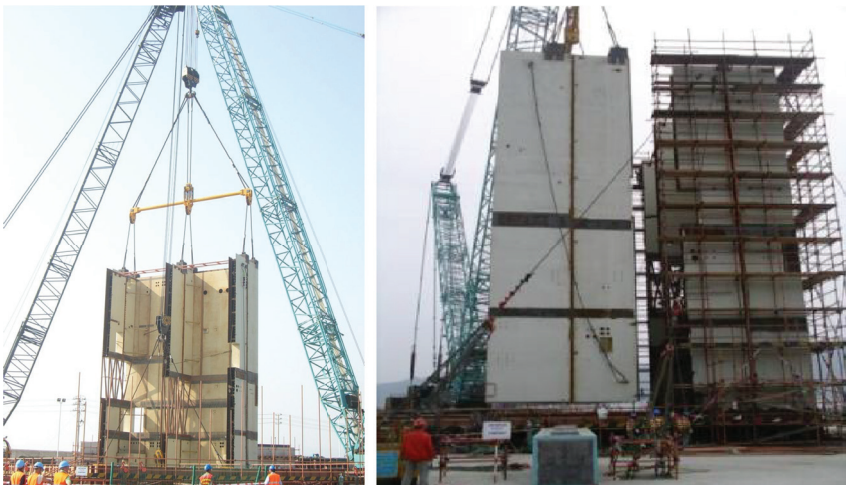
Рис. 11. Вывешивание и сборка предварительно укрупненных на стенде элементов блока СА20 краном высокой грузоподъемности на АЭС Sanmen (Китай) 9 [10]
