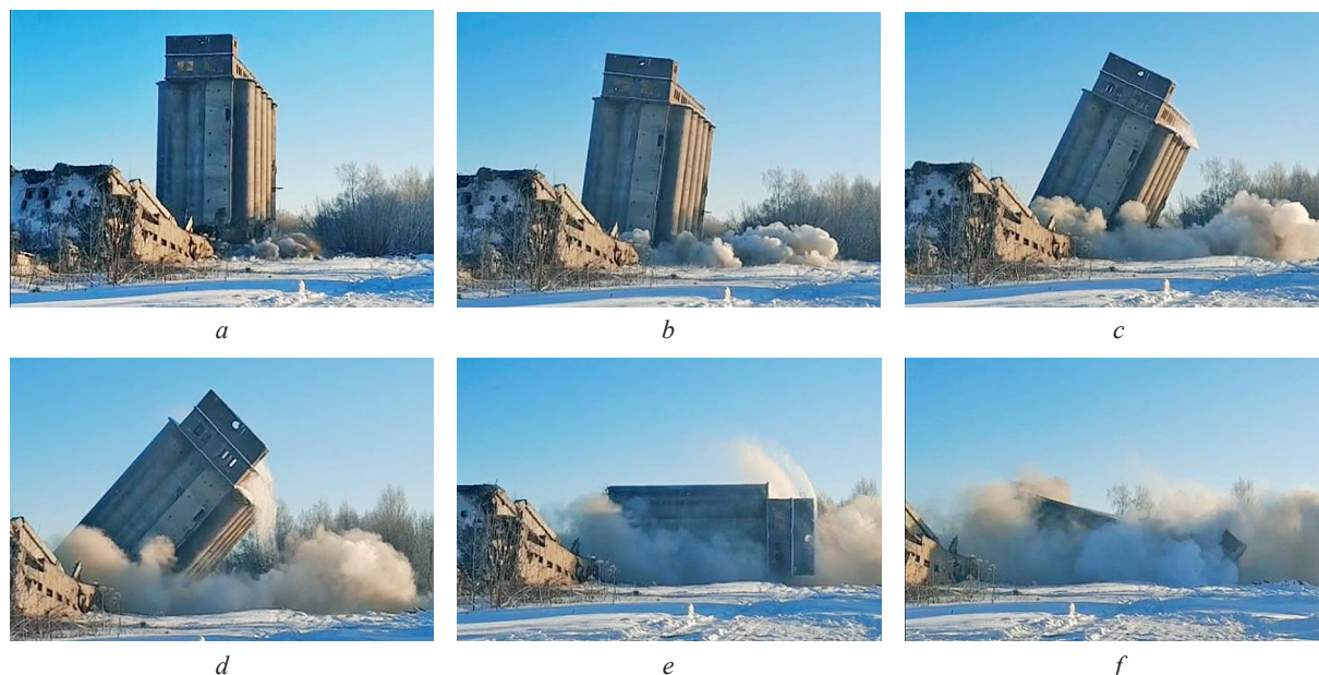
Рис. 7. Обрушение силосного корпуса по предложенной технологии через: a — 0 с после подрыва; b — 1 с; c — 2 с; d — 3 с; e — 4 с; f — 5 с
