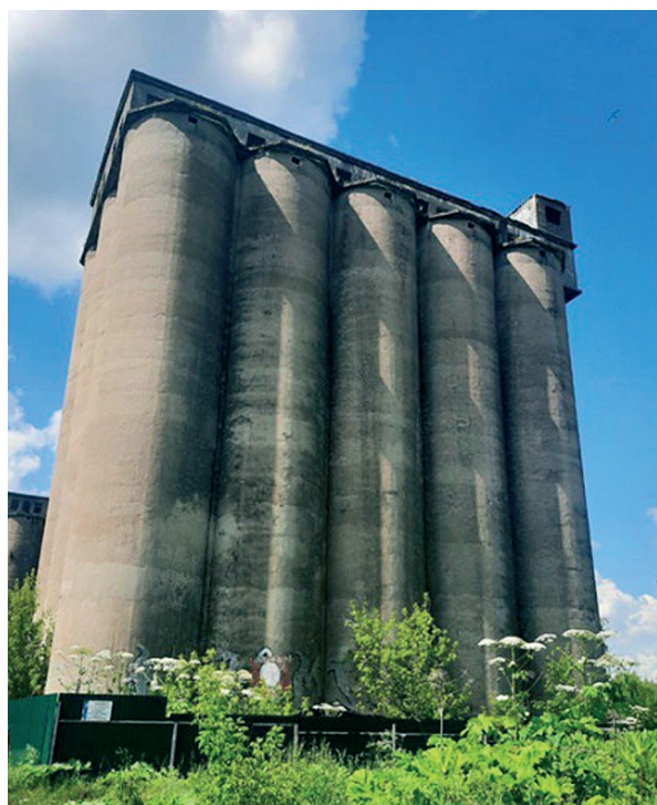
Рис. 2. Элеватор из монолитного железобетона в г. Ярославле
