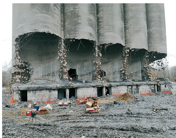
Рис. 6. Силосный корпус, подготовленный к взрыву
