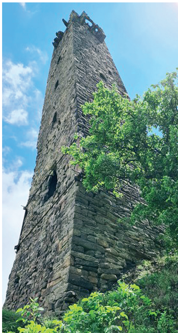
Рис. 3. Дерская башня до реставрации. Фото 2009 г. [21, 22]
