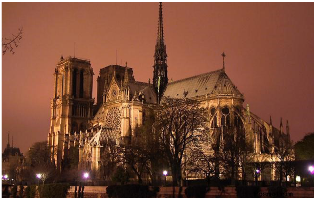
Рис. 8. Южный фасад здания собора
