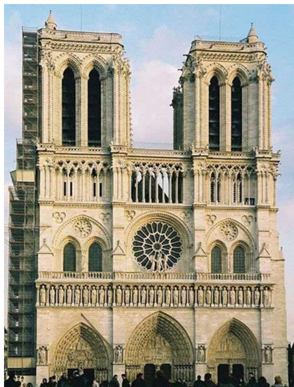
Рис. 7. Западный фасад здания собора
