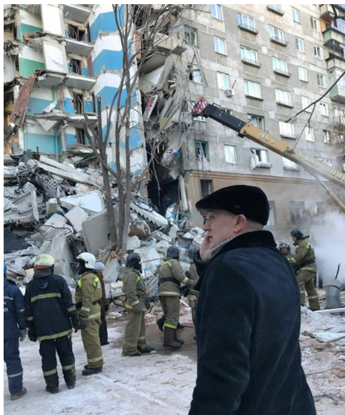
Рис. 5. Зона прогрессирующего обрушения строительных конструкций после взрыва в жилом здании в г. Магнитогорск, 31 января 2018 г.
