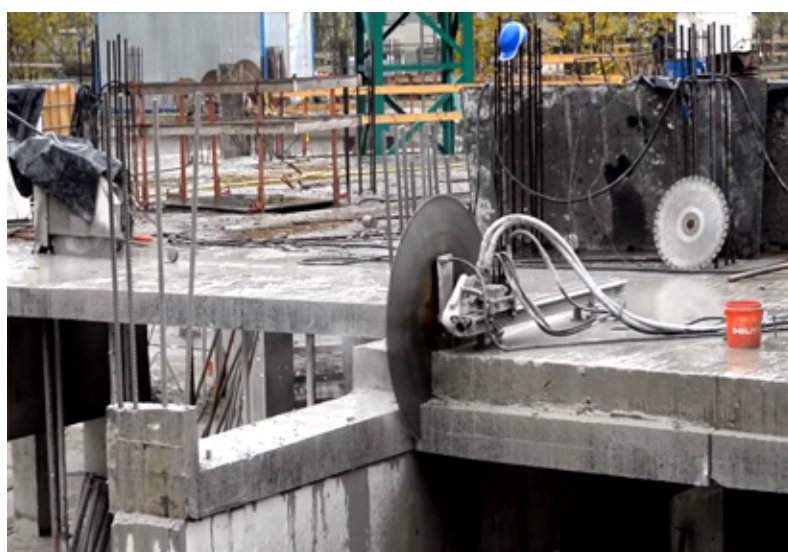
Рис. 5. Применение алмазной резки при поэлементной разборке зданий и сооружений
