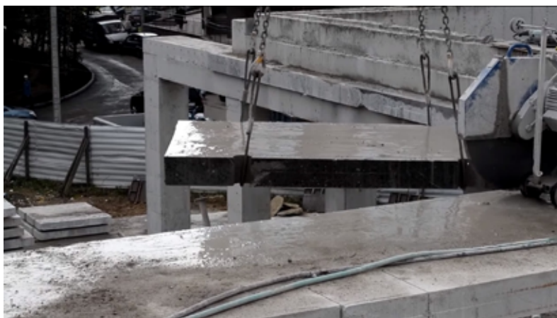
Рис. 6. Конструкции, образовавшиеся при алмазной резке
