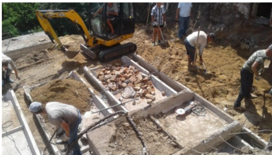
Рис. 10. Устройство столбчатого фундамента из ранее использованных железобетонных ребристых плит
