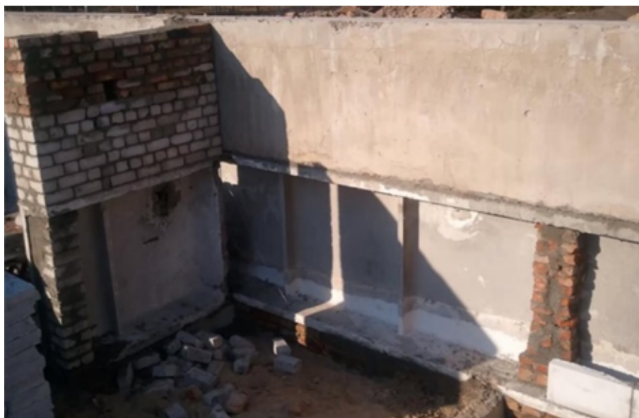
Рис. 11. Конструкция столбчатого фундамента
