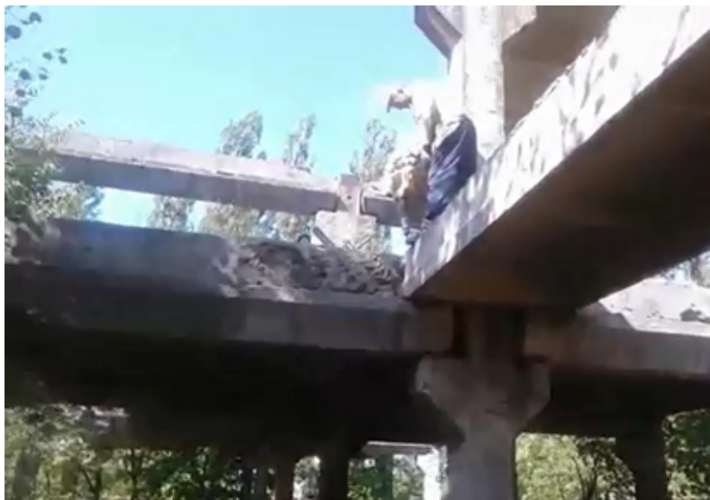
Рис. 4. Пример поэлементной разборки железобетонного каркаса с применением отбойных молотков
