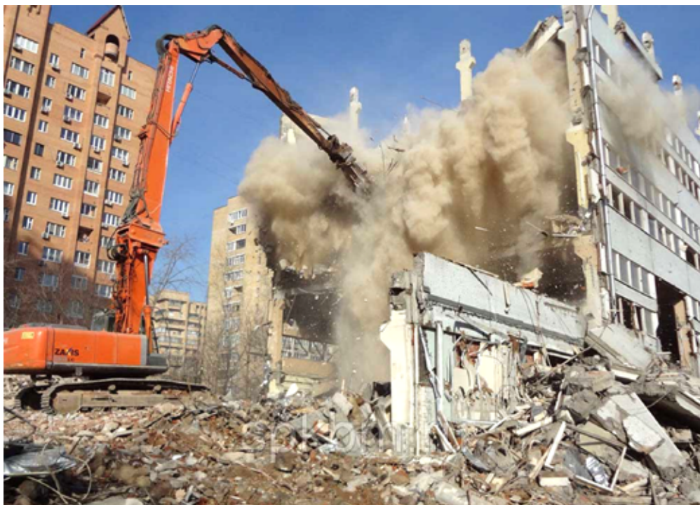
Рис. 2. Применение гусеничной техники с использованием гидромолота при механизированном сносе здания Fig. 2. Usage of the tracked vehicle-based hydraulic hammer in mechanized building demolition
