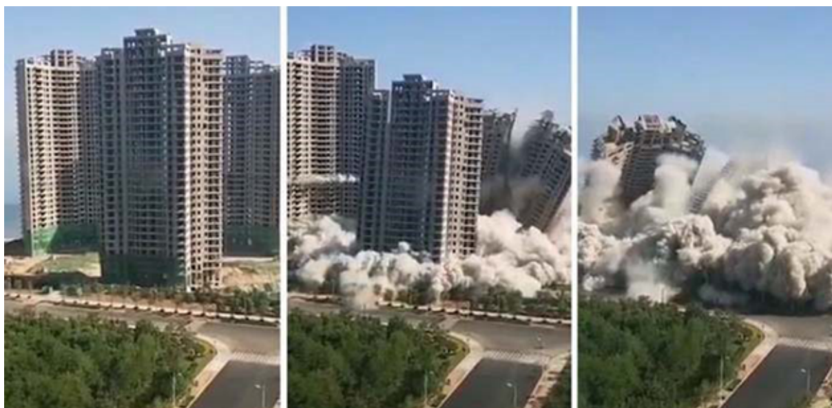
Рис. 1. Снос зданий методом взрыва
