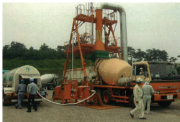
Рис. 6. Впрыск жидкого азота в емкость бетоновоза [52]
