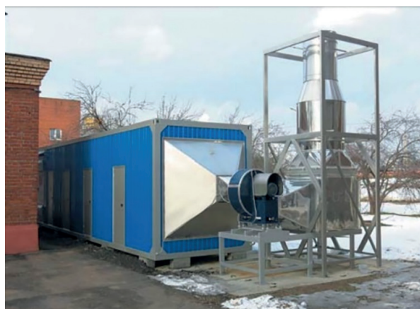
Рис. 10. Установка ВЕНТЛИТ производительностью 10 тыс. м³/ч для удаления дурно пахнущих вентиляционных выбросов
