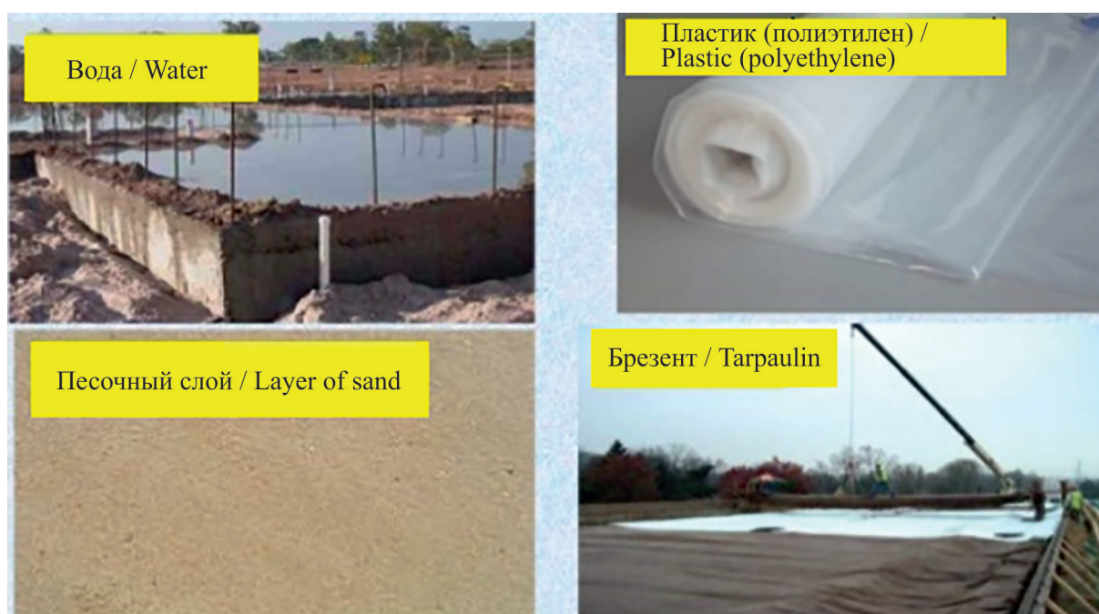
Рис. 9. Применение теплоизоляционного слоя на поверхности [64, 65]
