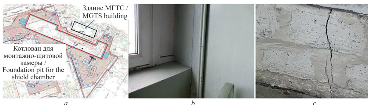
Рис. 1. Здание, расположенное в зоне влияния котлована для сооружения монтажно-щитовой камеры станционного комплекса «Стахановская улица»: a — схема расположения здания; b — трещина на стыке стены и перегородки раскрытием до 1 мм; c — трещины в цоколе раскрытием до 3 мм
