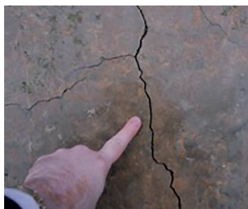
Рис. 1. Температурные трещины на поверхности бетона
