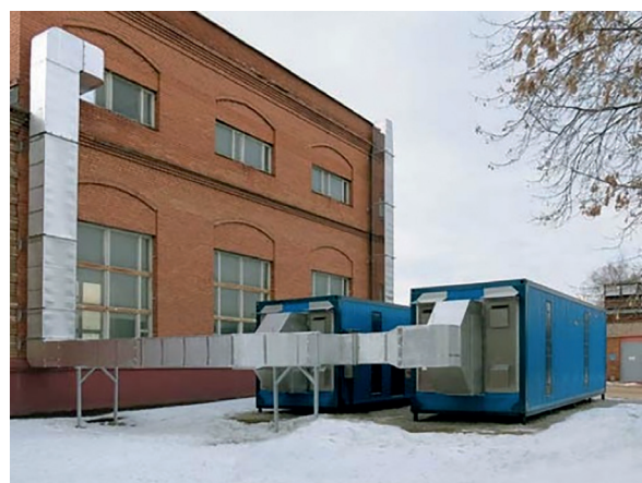
Рис. 11. Здание решеток цеха механической очистки воды с четырьмя установками ВЕНТЛИТ МСД-10000
