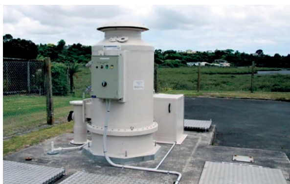
Рис. 6. Угольный фильтр с вентилятором и насадкой для ослабления акустических шумов
