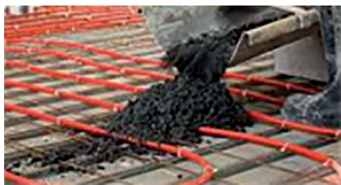
Рис. 7. Распределение труб системы охлаждения в бетонном блоке
