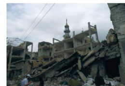
4 — Полное разрушение / Complete destruction
