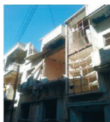
2 — Средняя степень разрушения / Moderate damage
