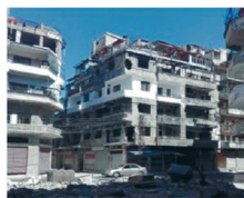
1 — Слабое разрушение / Light damage
