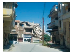
3 — Сильная степень разрушения / Grave damage
