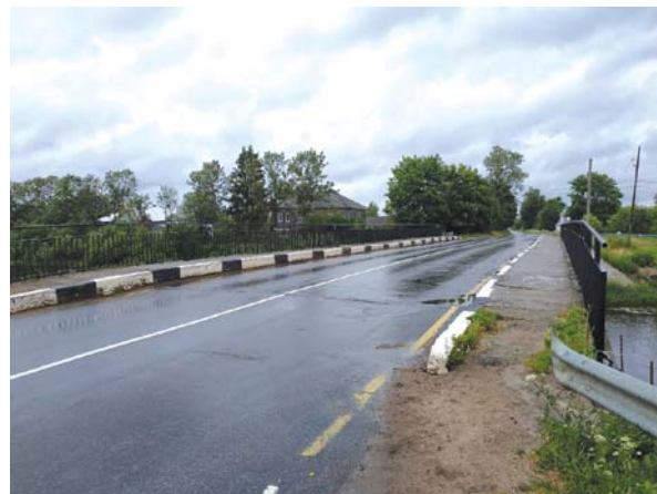
Рис. 2. Общий вид покрытия моста
