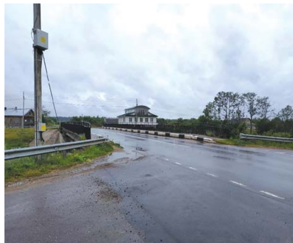
Рис. 3. Общий вид подхода к мосту
