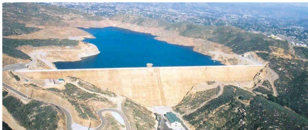
Рис. 1. Плотина из укатанного бетона Оливенхайн, США, 2004
