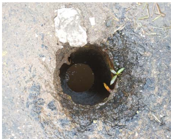
Рис. 7. Водосброс в начале моста
