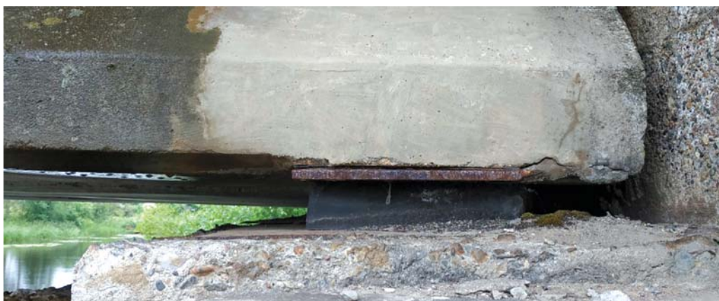
Рис. 10. Опорные части
