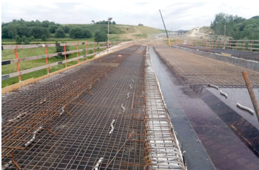
Рис. 3. Строительство магистральной железной дороги с применением конструкций безбалластного пути
