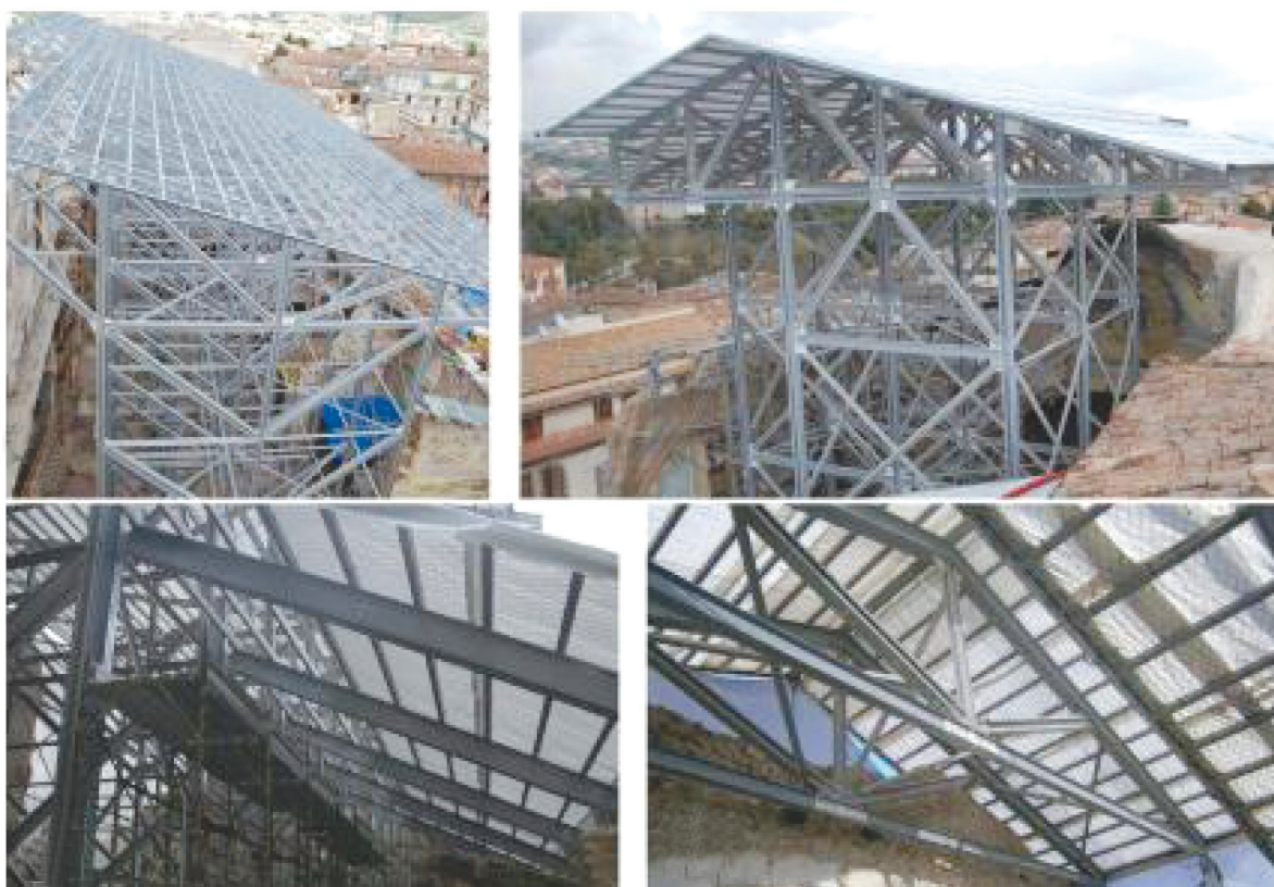
Рис. 3. Целлюлознокомпозитная стеклопластиковая решетчатая конструкция
