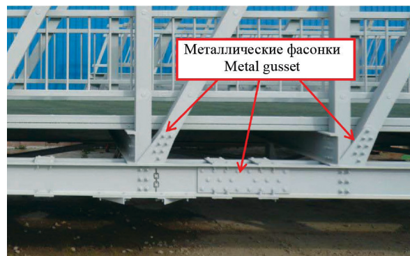
Рис. 2. Узловые соединения решетчатых пролетных строений, выполненные Научно-производственным предприятием «АпАТэК»
