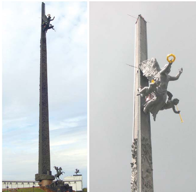
Рис. 1. Слева — общий вид памятника Победы на Поклонной горе в г. Москве. Справа — скульптурная группа, установленная вблизи вершины сооружения. За скульптурной группой виден механический гаситель колебаний первого тона изгиба Fig. 1. Left photo. The overall view of the Victory Monument on Poklonnaya Hill, Moscow. Right photo. The statuary installed close to the top of the structure. The mechanical damper of first-mode flexural vibrations is visible behind the statuary
