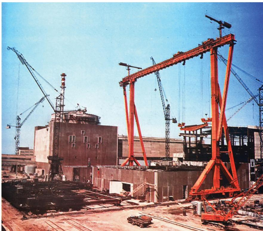
Рис. 1. Козловой кран K2×100/190/380 (справа) и плаза-кондуктор (слева) на сооружении Балаковской АЭС
