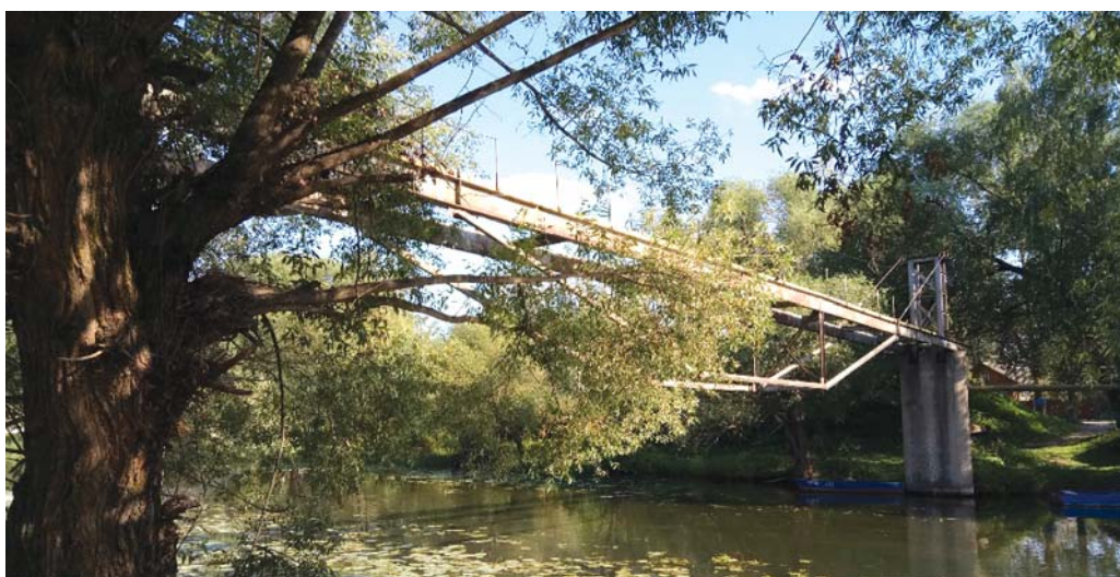
Рис. 1. Технологический трубопровод с несущей металлической конструкцией из вант и поддерживающей фермы через р. Трубезь в г. Переславль-Залесский Ярославской области
