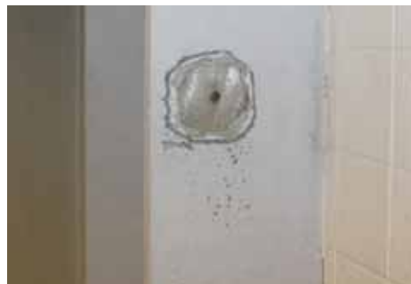
Поверхность стального элемента № 1 после зачистки поверхности, проведения натурных испытаний твердомером и отбора образца
