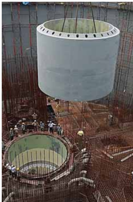
Рис. 2. Монтаж СЗ в сборе
