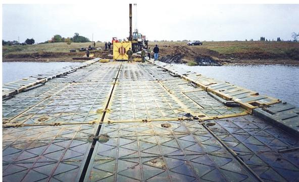
Рис. 8. Понтонный мост для размещения стрелового крана [68]
