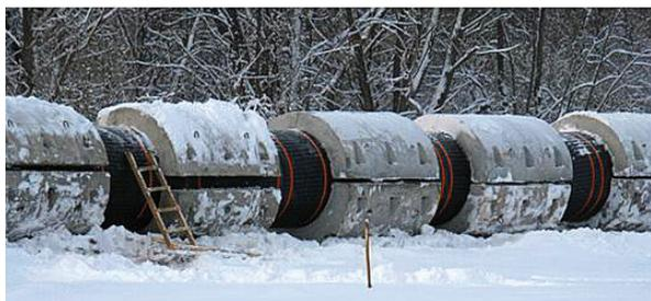
Рис. 11. Железобетонные утяжелители для подводного перехода трубопровода [68]
