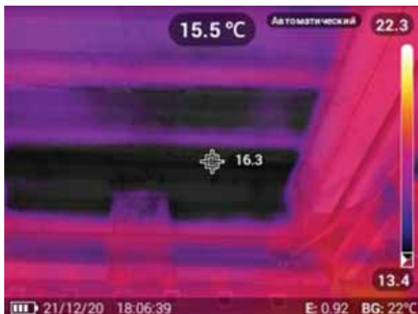
Рис. 4. Термограмма зоны над открытым люком в грабельном отделении насосной станции, полученная с помощью тепловизора Fluke TiS20+
