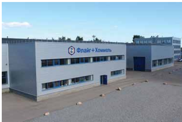
Рис. 5. Общий вид цеха металлообработки компании ООО «Флайг+Хоммель»
