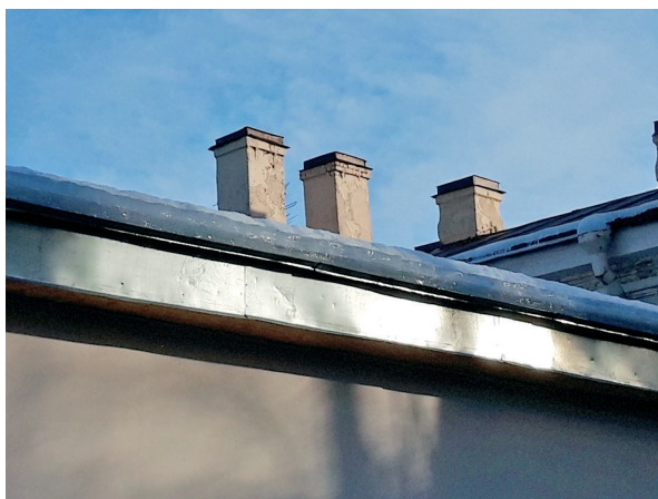
Рис. 1. Ледяная дамба на холодном участке карнизного свеса Fig. 1. An ice dam on the cold section of an eaves edge
