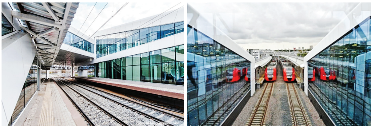
Рис. 2. Станция МЦК «Окружная»
