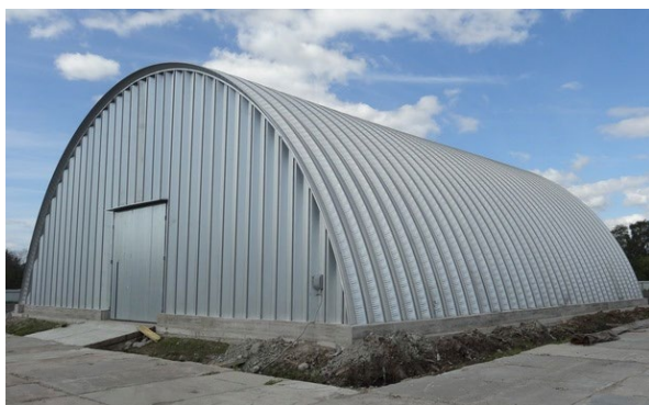
Рис. 1. Общий вид ангара с арочным покрытием
