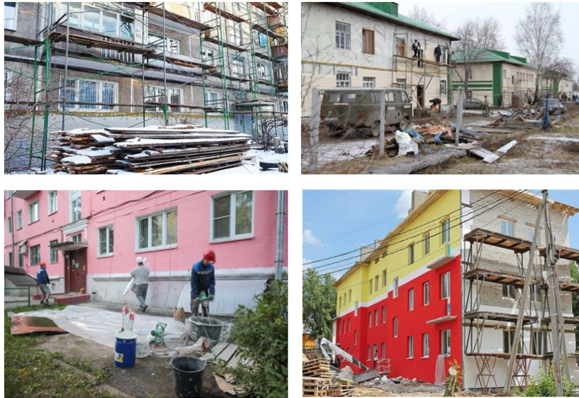
Рис. 2. Фотофиксация организации площадок капитального ремонта общего имущества МКД без разработки проекта организации ремонтно-строительной площадки [16]
