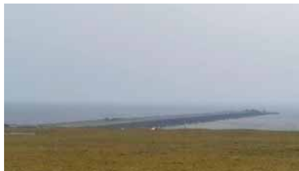
Рис. 2. Сооружение соединительной дамбы протяженностью более 1,5 км соединит береговую зону и грузовой причал для отгрузки угля. Начало работы по отсыпке дамбы
