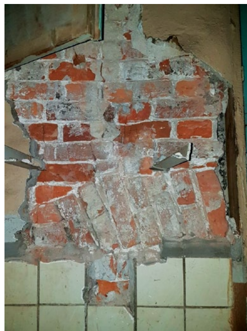
Рис. 6. Москва. Восточный флигель усадьбы Мусиных-Пушкиных по Спартаковской улице. Фрагмент стены (с арочной перемычкой) в интерьере здания. Фото 2022 г.
