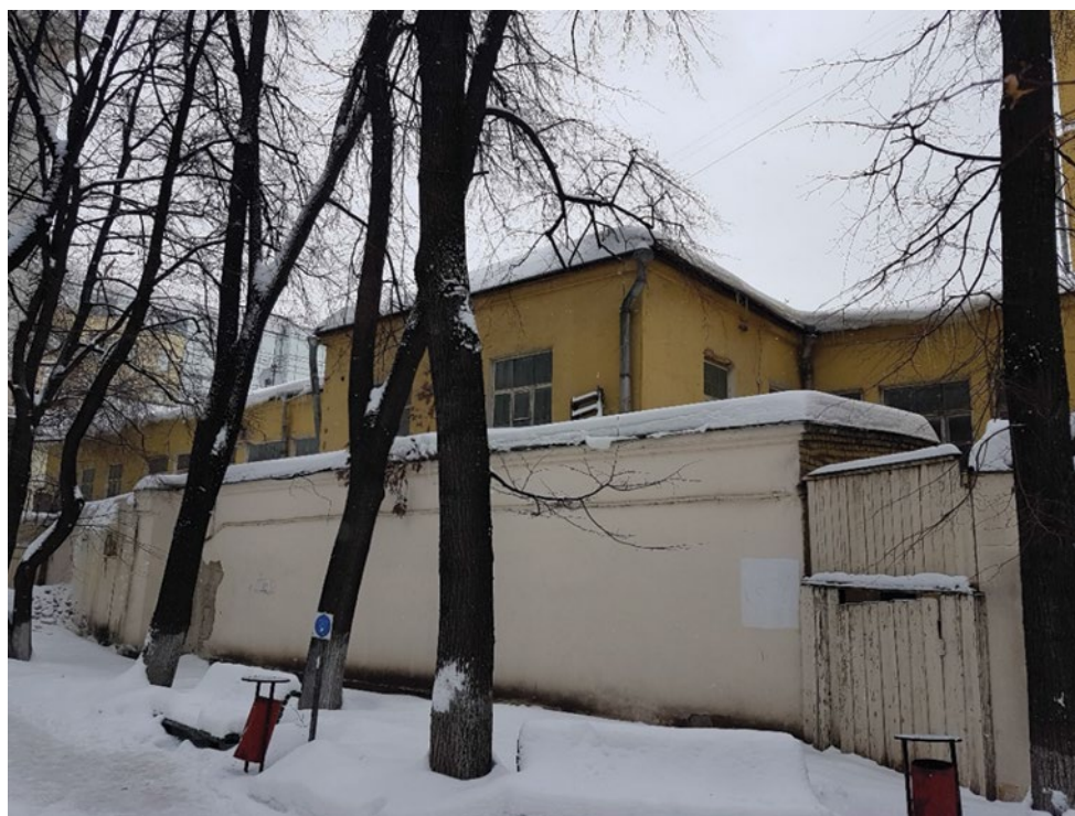
Рис. 2. Москва. Восточный флигель усадьбы Мусиных-Пушкиных по Спартаковской улице. Вид восточного фасада. Существующее состояние. Фото 2021 г.
