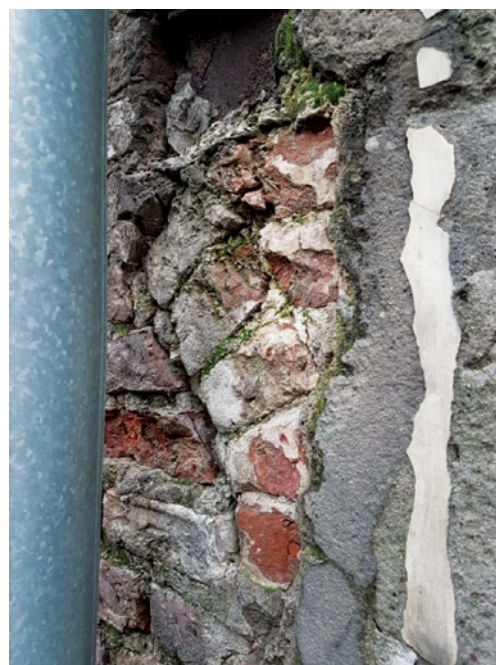
Рис. 7. Москва. Восточный флигель усадьбы Мусиных-Пушкиных по Спартаковской улице. Пята арочного проема, выявленная зондажом на западном фасаде здания. Фото 2022 г.
