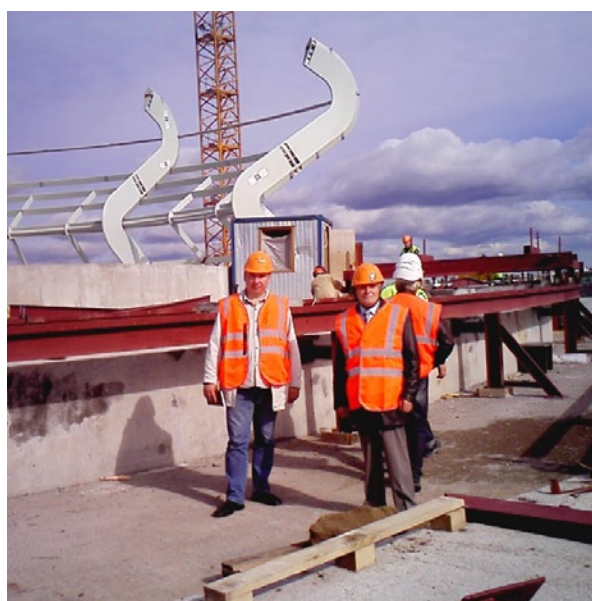
Рис. 2. Установка на отметке +44,7 м объекта «Невская Ратуша» 32 т специальной технологической оснастки для монтажа 24 пар составных 5-тонных элементов металлоконструкций купола покрытия атриума, диаметр 28 м. Проектировщики: доктор технических наук Л.М. Колчеданцев (справа), кандидат технических наук В.В. Сокольников, кандидат технических наук А.Д. Дроздов (СПбГАСУ)
