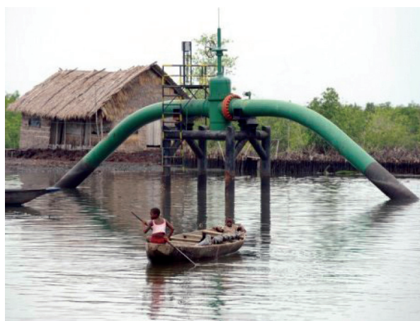
Рис. 2. Авария на подводном трубопроводе компании ExxonMobil, Нигерия. Прорыв трубопровода в дельте р. Нигер (1998 г.)
