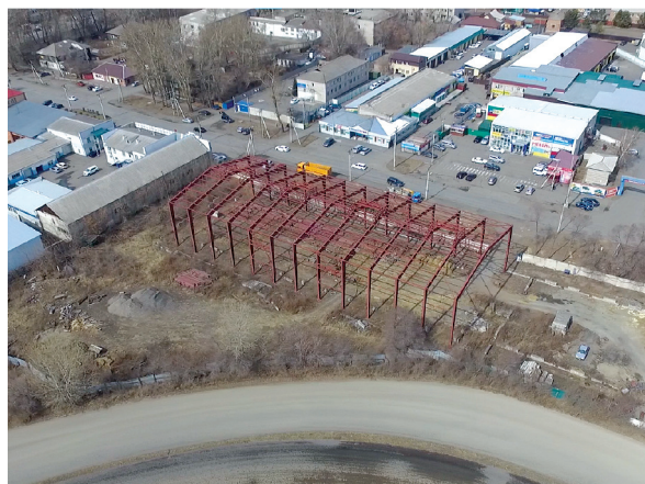
Рис. 3. Каркас здания школы верховой езды в г. Абакане с высоты (фото авторов)
