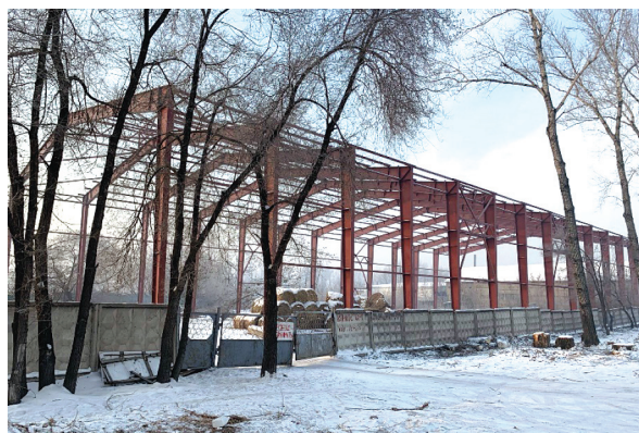
Рис. 1. Существующий каркас здания школы верховой езды в г. Абакане (фото авторов)
