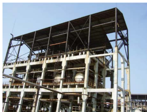
Рис. 1. Общий вид сооружения
