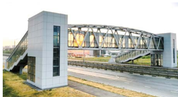
Рис. 4. Пешеходный мост в г. Тула, пролет 40,1 м
