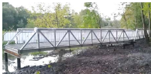
Рис. 5. Пешеходные мосты в пойме р. Яуза (г. Москва), пролеты — 10 м, опирание на сваи, погруженные в вязкий береговой грунт
