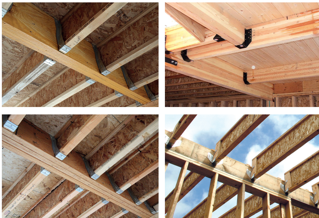
Рис. 1. Примеры традиционного крепления балок перекрытия к стене и ригелям 2
