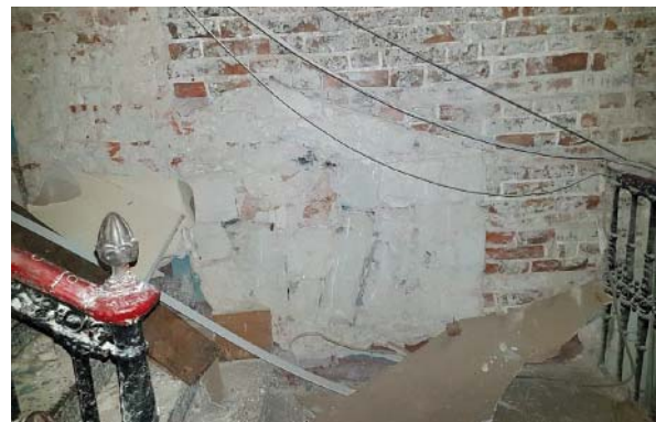
Рис. 10. Москва. Главный дом усадьбы Мусиных-Пушкиных по Спартаковской улице. Зондаж по второму ярусу северного фасада дома Д.А. Шепелева. Фрагмент срубленного оконного наличника из белого камня с сандриком в виде фронтона и отделка плоскости стены рустом. Фото 2022 г.
