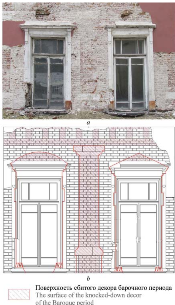
Рис. 12. Москва. Главный дом усадьбы Мусиных-Пушкиных по Спартаковской улице: а — зондаж по второму ярусу восточного фасада дома Д.А. Шепелева. Следы срубленных оконных наличников, пилястры с белокаменной базой и капителью и венчающего карниза. Фото 2022 г.; б — фиксация зондажа по второму ярусу восточного фасада дома Д.А. Шепелева. Следы срубленных оконных наличников, пилястры с белокаменной базой и капителью и венчающего карниза
