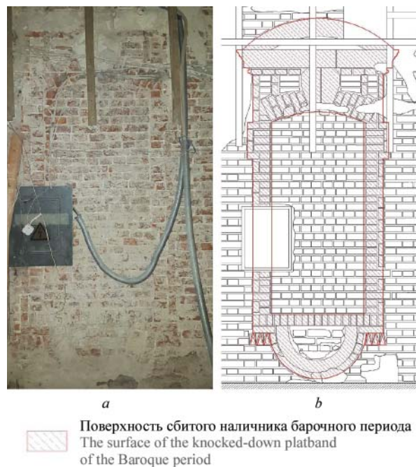
Рис. 11. Москва. Главный дом усадьбы Мусиных-Пушкиных по Спартаковской улице: а — зондаж по второму ярусу северного фасада дома Д.А. Шепелева. Срубленный оконный наличник. Фото 2022 г.; б — фиксация зондажа по второму ярусу северного фасада дома Д.А. Шепелева. Оконный наличник
