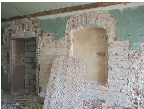
Рис. 9. Москва. Главный дом усадьбы Мусиных-Пушкиных по Спартаковской улице. Зондаж по первому этажу северного фасада дома Д.А. Шепелева, где фиксируются оконный и дверной проемы, рустовка и фрагмент стесанной пилястры. Фото 2022 г.
