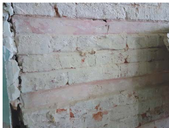
Рис. 13. Москва. Главный дом усадьбы Мусиных-Пушкиных по Спартаковской улице. Зондаж по первому этажу северного фасада дома Д.А. Шепелева. Рустовка стен со следами обмазки и цветового решения фасада. Фото 2022 г.
