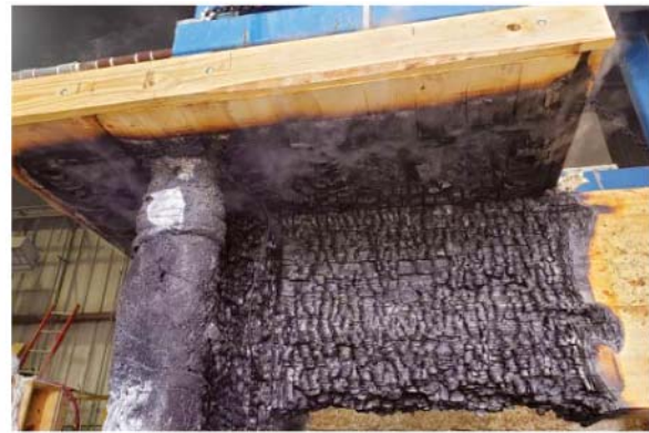
Проверка проведена Tested assembly
