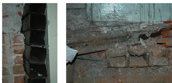
Рис. 8. Конструкция печного отопления в стене и в полу (фотографии А.И. Клименко, 2002 г.)
