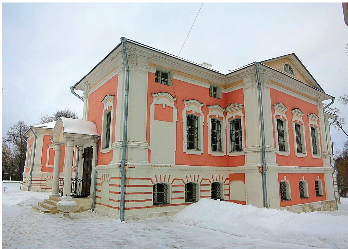
Рис. 15. Главный дом усадьбы Лопасня-Зачатьевское. 1770-е гг. Московская область, г. Чехов, ул. Пушкина, д. 10 (URL: rasfokus.ru/photos/cat/new/photo2298207.html )
