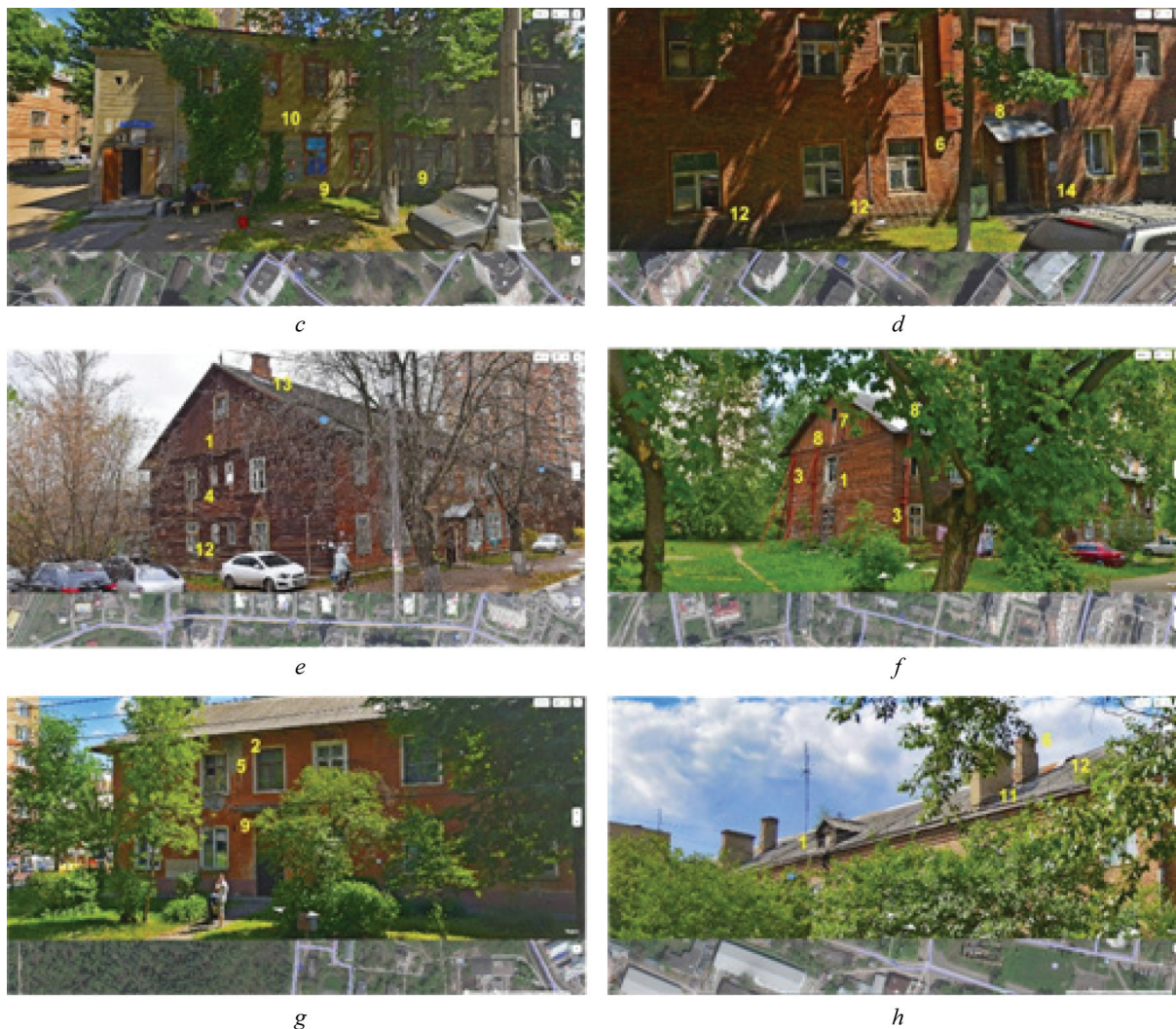
Рис. 6. (окончание) Примеры аварийных зданий (Яндекс карты): c — ул. Зеленая, д. 7 (2018 г.); d — ул. Зеленая, д. 5 (2018 г.); e — мкр. Ольгино, ул. Жилгородок, д. 17 (2017 г.); f — мкр. Ольгино, ул. Жилгородок, д. 30 (2018 г.); g — ул. Орджоникидзе, д. 15 (2018 г.); h — мкр. Кучино, ул. Почтовая, д. 2А (2018 г.)
