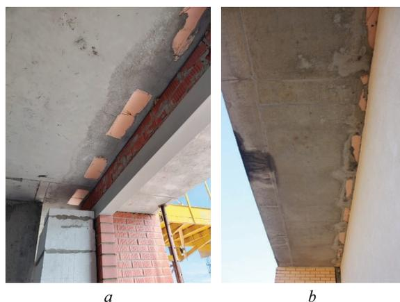
Рис. 3. Фрагменты диска перекрытия и балконной плиты с перфорацией: *a* — фактическое размещение шага перфорации диска перекрытия; *b* — фрагмент балконной плиты с перфорацией под термовкладыши и зоной локальных повреждений
