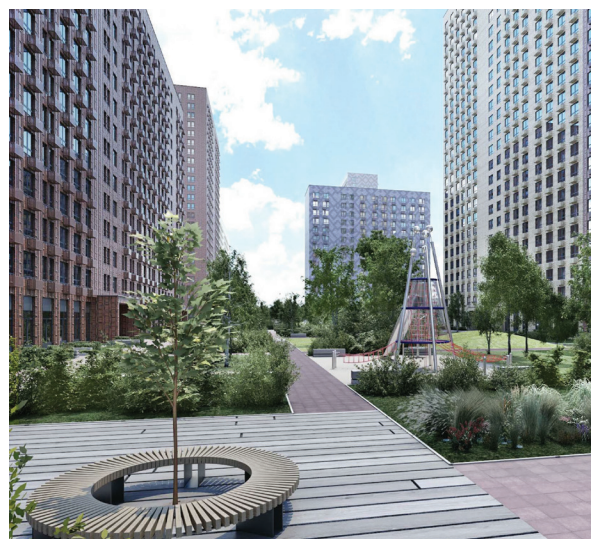
Рис. 10. Жилой комплекс «Мякинино парк», г. Москва
