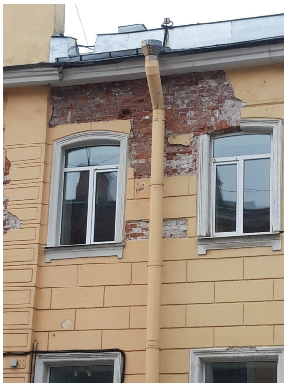
Рис. 2. Повреждение штукатурного покрытия с выпадением отдельных его фрагментов
