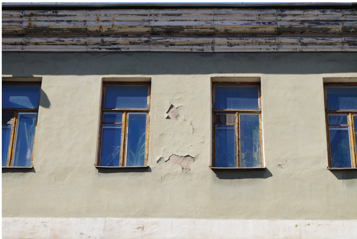
Рис. 1. Разрушение отделочного слоя штукатурного покрытия
