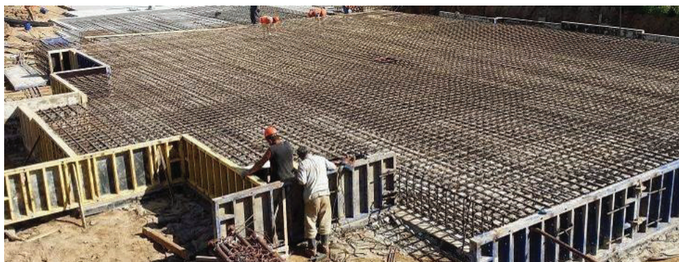
Рис. 6. Армирование фундаментной плиты 17-этажного жилого дома в ЖК «Дрожжино-2», д. Дрожжино, Московская обл. (URL: https://galencomposite.ru/ )
