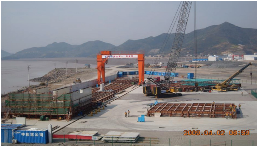
Рис. 9. Сборочная площадка АЭС Sanmen (Китай) [15]
