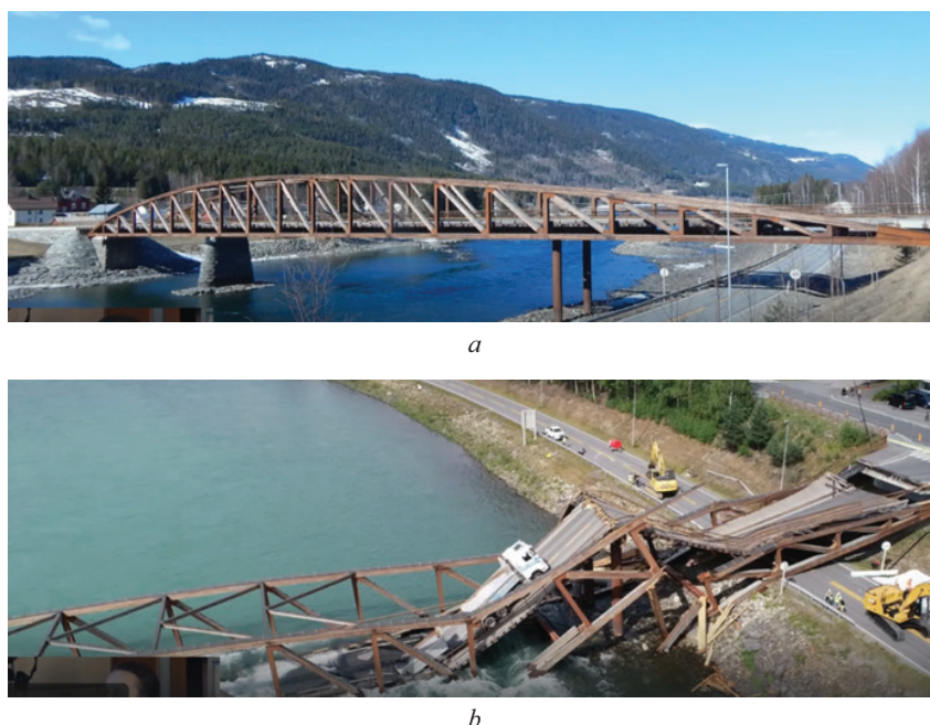
Рис. 4. Мост до обрушения (а) и обрушение деревянного моста (b) у д. Треттен (Норвегия)
