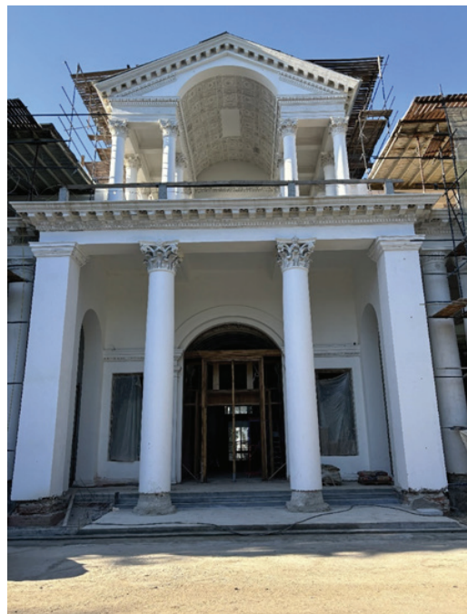
Рис. 1. Главный фасад. Процесс реставрационных работ Fig. 1. The main facade. The process of restoration work
