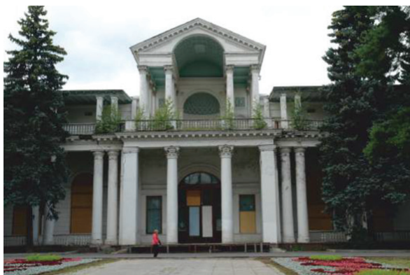
Рис. 8. Главный фасад до начала проектных работ 2020 г. [21]
