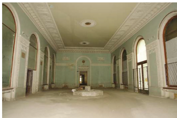
Рис. 9. Интерьер банкетного зала 2020 г. до начала проектных работ
