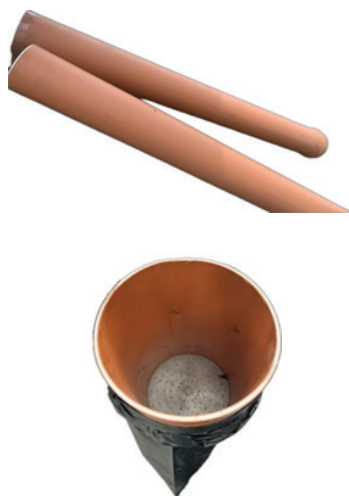
Рис. 2. Подготовка опалубочной конструкции
