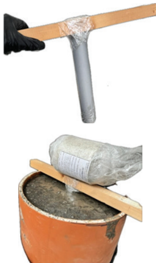
Рис. 4. Конструкция опалубки сваи, монтаж Fig. 4. Pile formwork construction, installation
