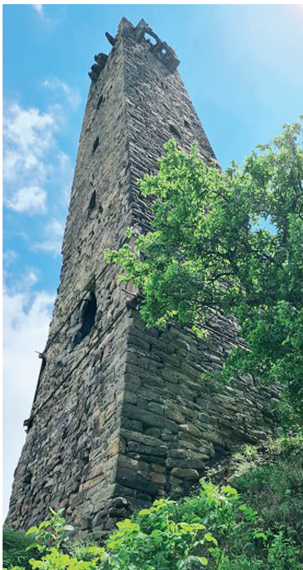
Рис. 3. Дерская башня до реставрации. Фото 2009 г. [21, 22]
