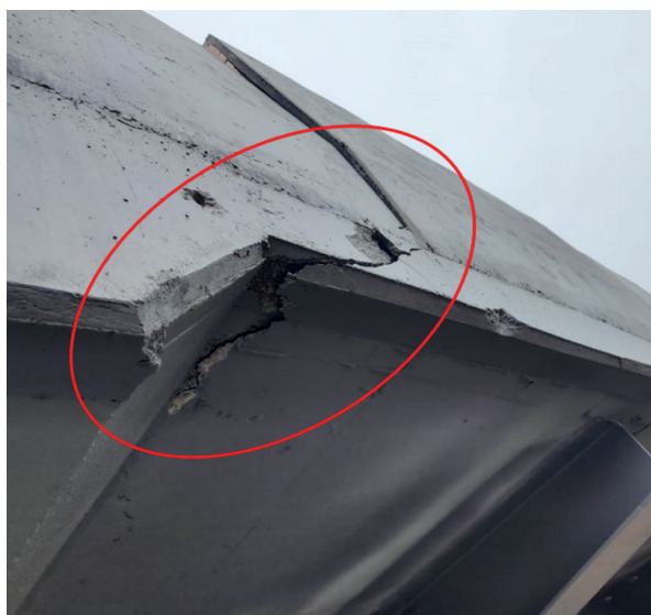
Рис. 2. Результаты удара грузового автомобиля о парапетное мостовое ограждение на эстакаде
