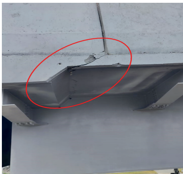
Рис. 2. Результаты удара грузового автомобиля о парапетное мостовое ограждение на эстакаде
