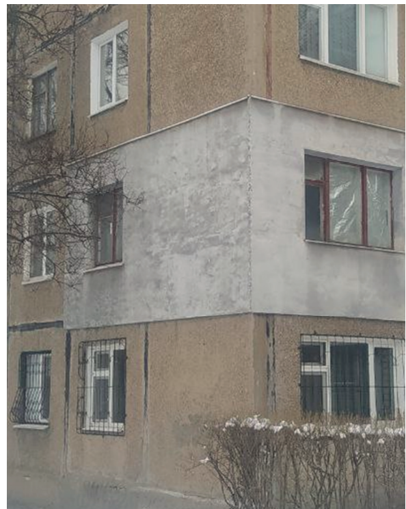
Рис. 5. Фото фасада здания
