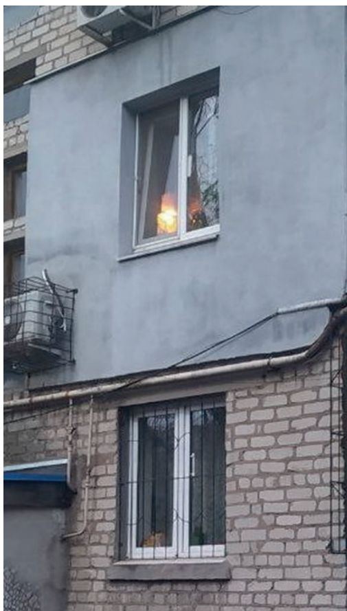
Рис. 2. Фото фасада здания
