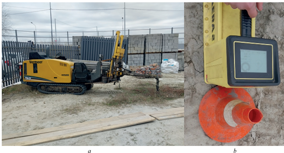
Рис. 2. Установка для выполнения горизонтально направленного бурения (Vermeer Navigator) (а); локационное оборудование (б)
