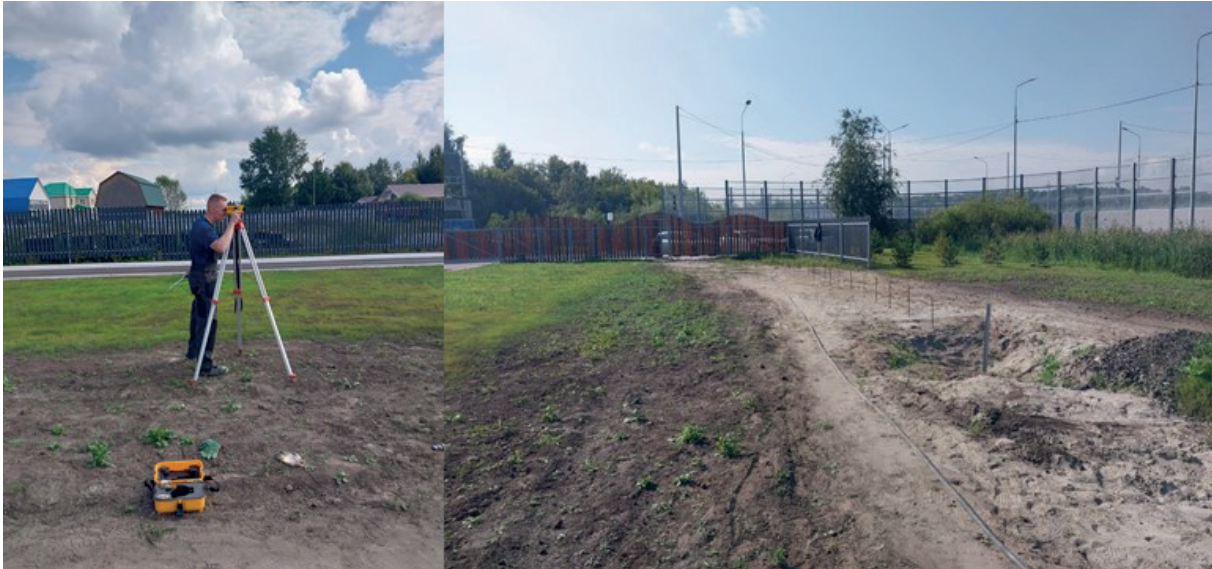
Рис. 8. Проведение геодезической съемки
