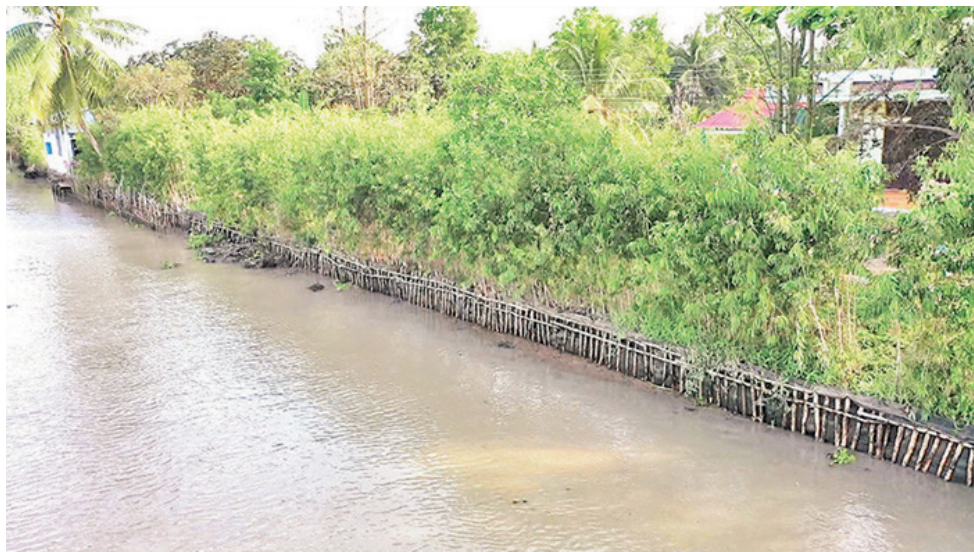
Рис. 4. Биоинженерное укрепление берега в районе Чау Тхань (дельта Меконга) (фото Google) Fig. 4. Bioengineered bank stabilization near Chau Thanh in the Mekong Delta, Vietnam (Google image)
